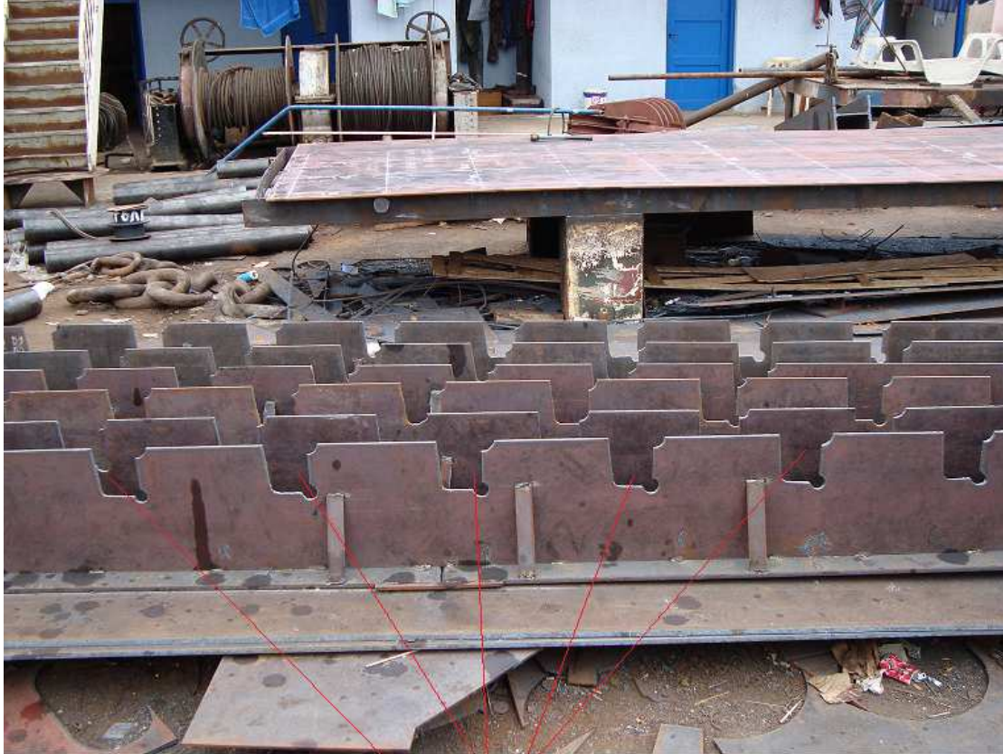
οπές διέλευσης ενισχυτικών
